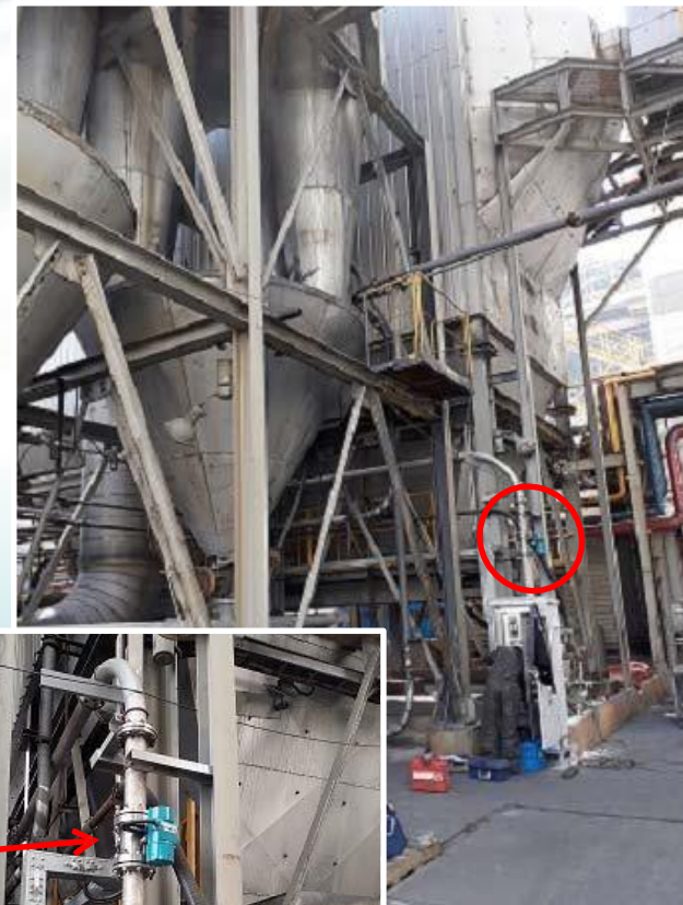
Stazione di scarico camion
