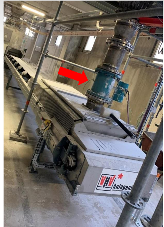
Flussometro DYNAmas montato
