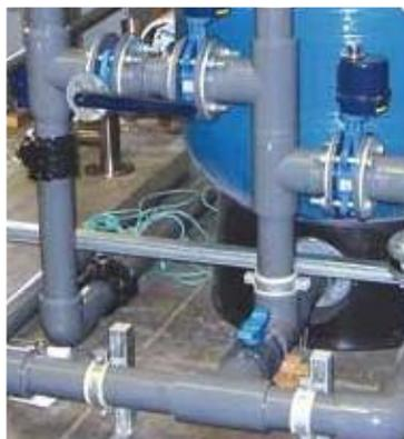
Le valvole controllano la portata del controlavaggio in un filtro per liquidi
